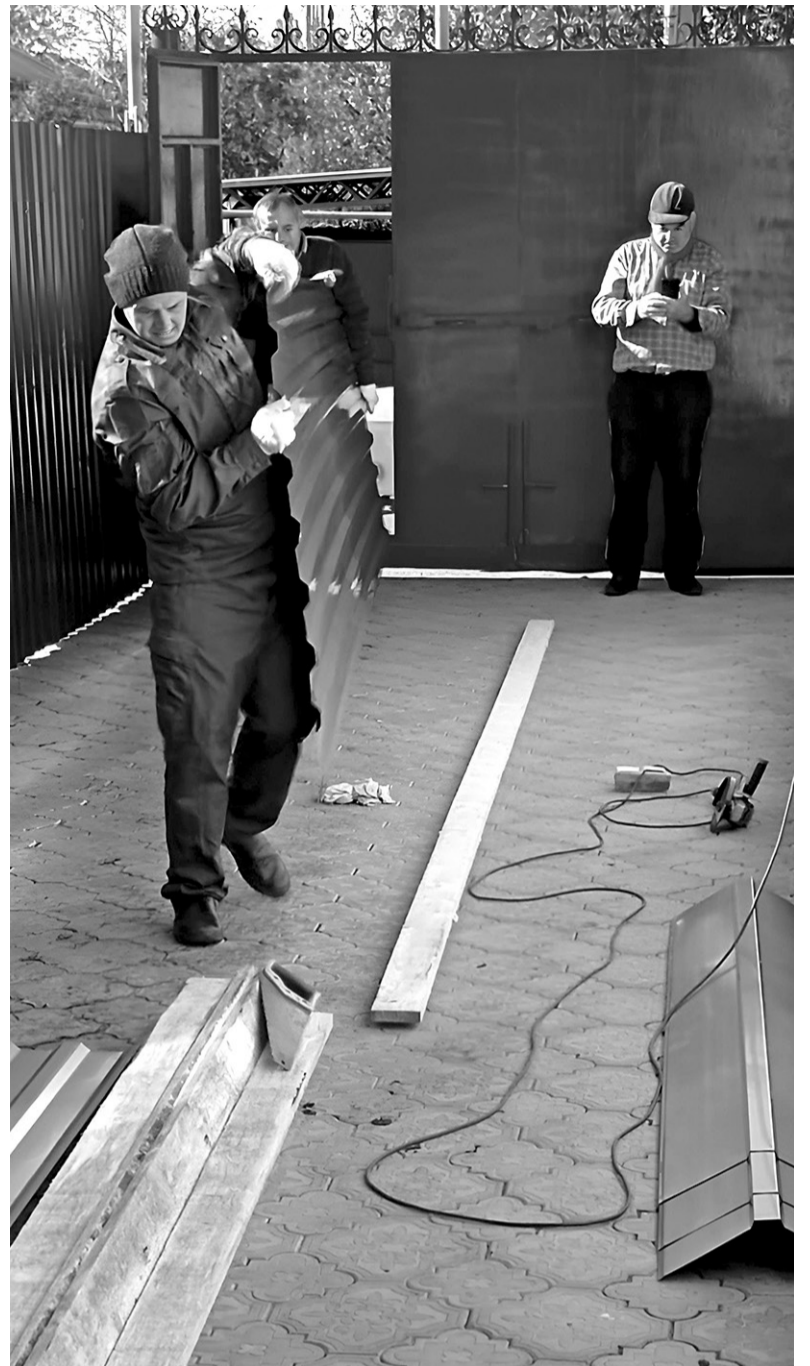
Идет подготовка к ремонту крыши дома семьи участника спецоперации
